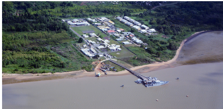
6.2.3.8.C. — Dégrad des Cannes. Appontement de la base navale (Flottille 25F – L. Gallego).
